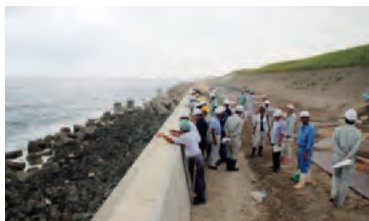
▲片山津海岸の工事の進捗状況を確認しました
